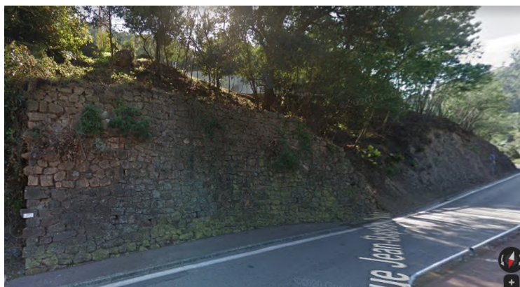
Figure 27 : Photo du mur-poids présent le long de la partie aval de la rue Jean-Baptiste Pastor
